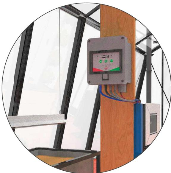
Ouvrir le boîtier de mesures, placer-le à une distance de 72cm du sol. Pointer au marqueur les emplacements de perçage (fixations, entrée et sorties électriques).
