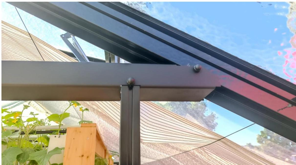
Aligner et fixer les pignons des deux serres à l'aide de vis-écrous M6 (contrepercer les profilés)
