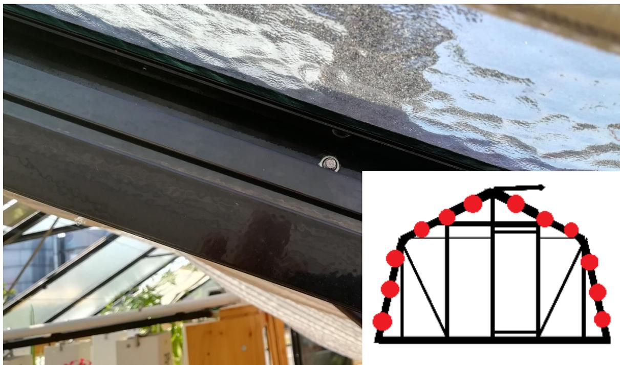
Coller avec du silicone, les lames d'aluminium sur toute la jonction extérieure des deux serres.
