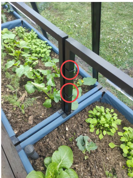
Câbles attachés avec des colliers de serrage
