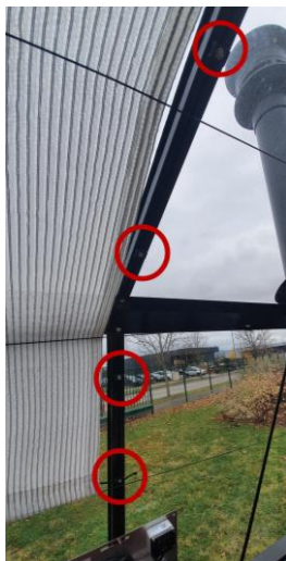
Emplacement du passage des câbles sur la façade n°1, faitière et façade n°2
