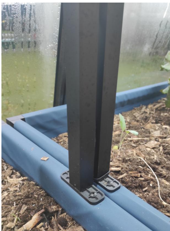
Assemblage de la structure support dans les connecteurs T
