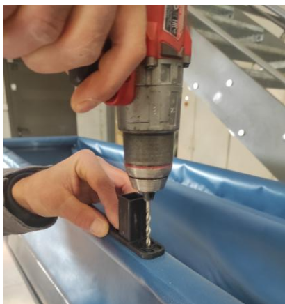
Perçage du bac perma
