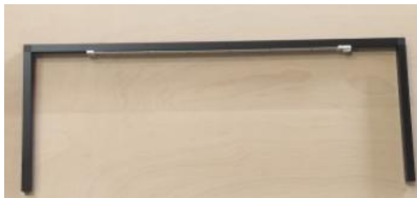
Assemblage de la structure de support bac perma
