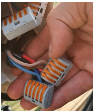
Répartition des câbles d'alimentation dans le boîtier de dérivation
