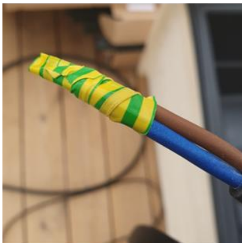
Câbles ligaturés pour faciliter l'insertion
