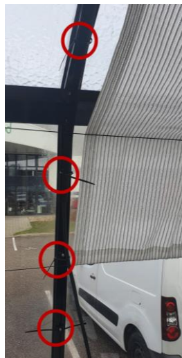
Emplacement du passage des câbles sur la façade n°1, faitière et façade n°2
