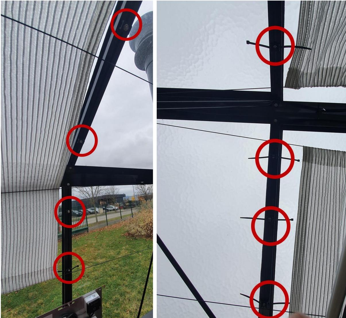
*Figure 5. Emplacement du passage des câbles façade #1 et faitière*
