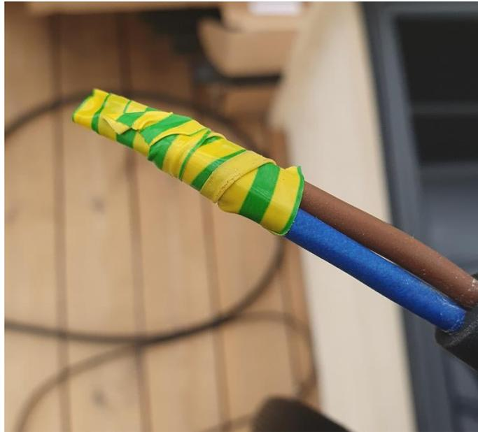
Figure 9. Câble ligaturé pour faciliter l'insertion
