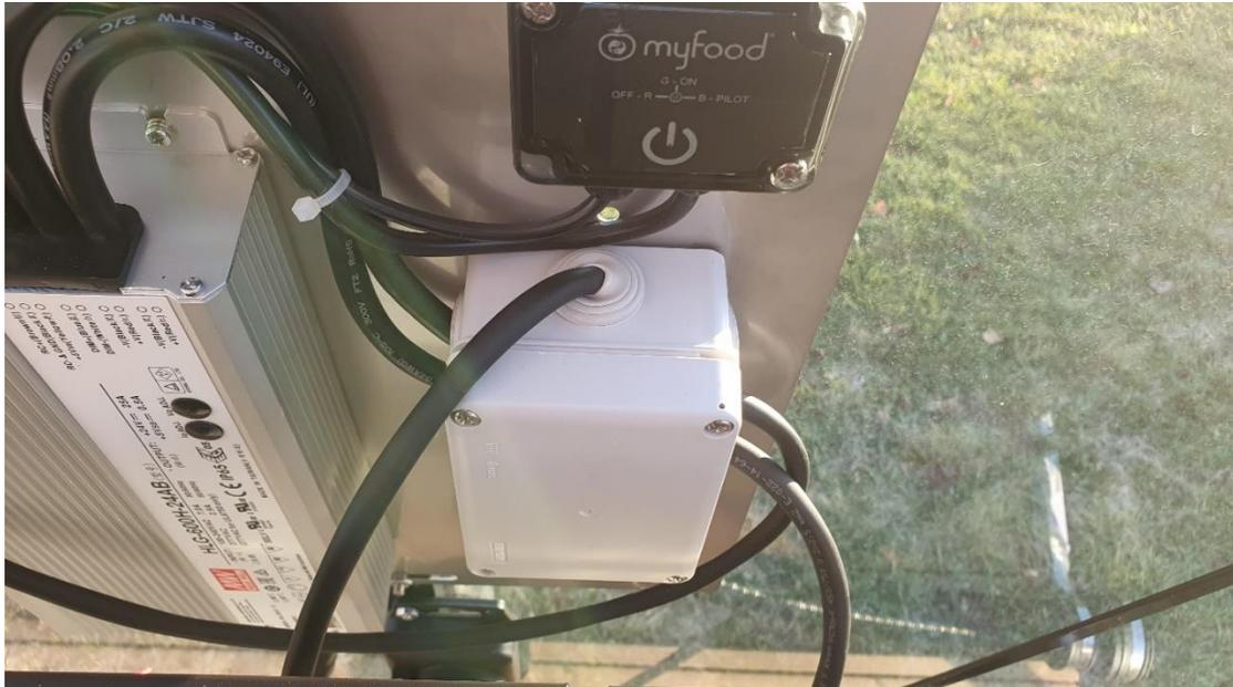
Figure 20. Boitier de dérivation avec le raccordement des câbles d'alimentation
