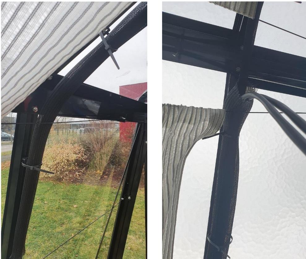
Figure 11. Fermeture des colliers et passage par le dessus de la faitière pour ne pas gêner l'ouverture de la toile d'ombrage
