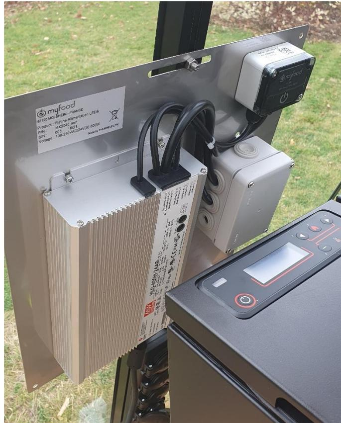
Figure 3. Fixation de la platine d'alimentation
