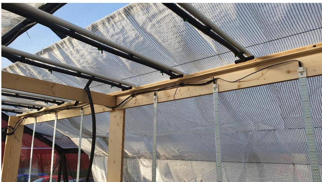
Figure 13. Passage de câble sur la structure en bois
