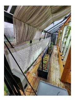
La toile d'ombrage latérale permet d'augmenter la surface ombragée et ainsi de limiter les fortes températures dans la serre.
