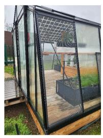
4. Reposer les joints dans la rainure du profilé en aluminium en les faisant glisser du bas vers le haut (laisser dépasser en haut et en bas pour éviter des infiltrations d'eau)
