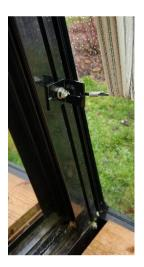
2. Fixer les 3 câbles de maintien d'un côté seulement à l'aide des manchons de serrage (2 câbles sur la même équerre que les toiles d'ombrage supérieures et l'autre sur l'équerre vers le bas de la serre). Utiliser une pince pour sertir le manchon.
