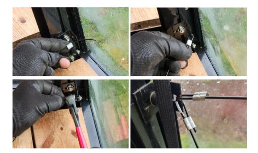
3. Faire passer la toile dans les 2 câbles de maintien supérieurs par le côté non fixé en repliant la toile en deux dans le sens de la longueur
